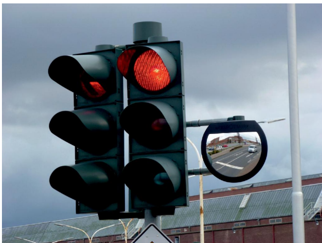
Spiegel gegen toten Winkel an Ampelanlage (Opel-Portal 60, Mainzer Straße, Rüsselsheim)
